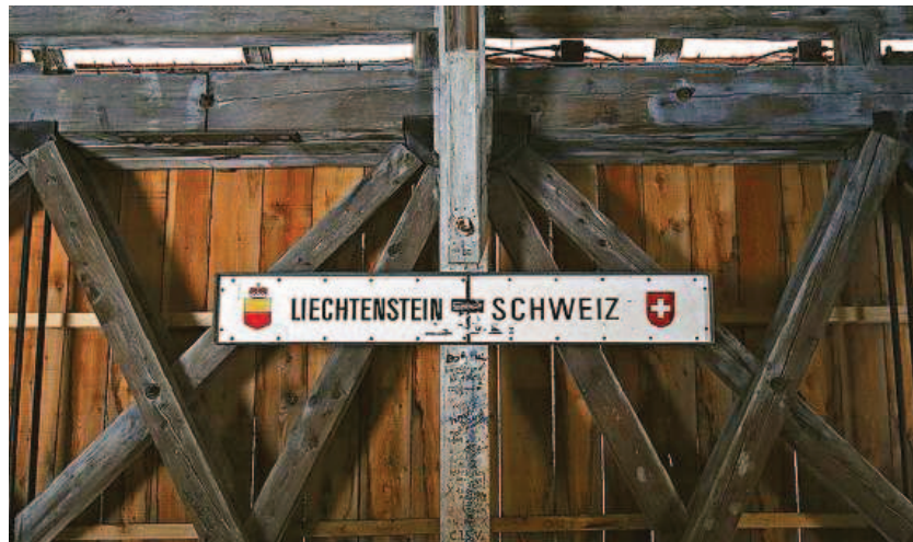
Der Weg über die Grenze ist für das Gewerbe gepflastert mit Vorschriften, Meldepflichten und Bewilligungen. Besserung ist nicht in Sicht. Bild: Elma Korac
