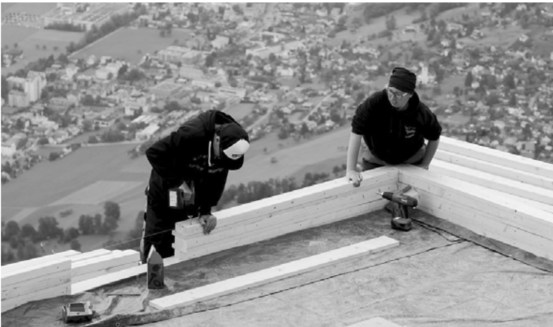
Abb. 7 Baustelle Crafting Wood (Bruno Klomfar, 2014)
