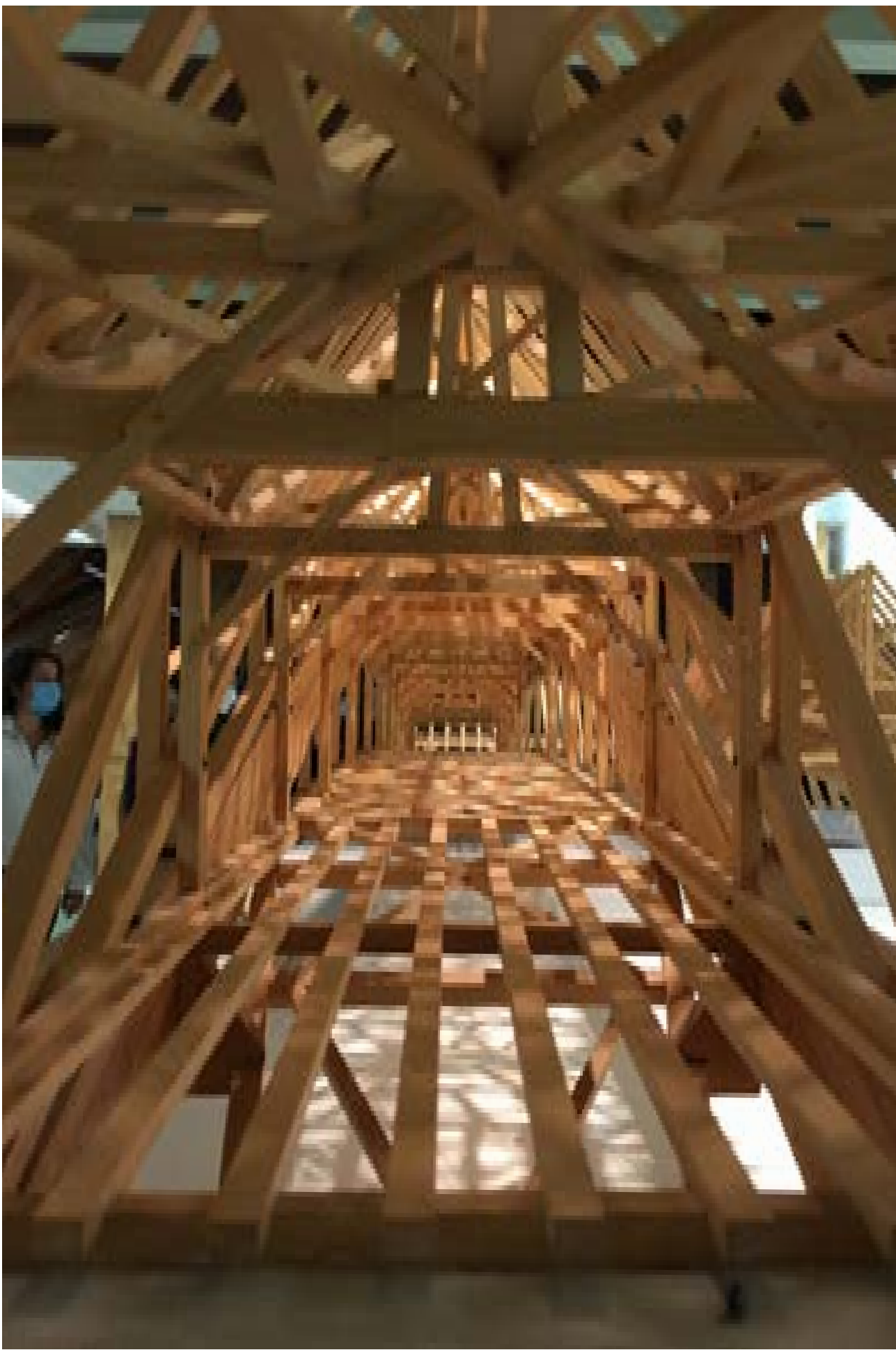
Modell Bogenbrücke über die Limmat bei Wettingen von H.U. Grubenmann, Zeughaus Teufen, Grubenmann - Museum
